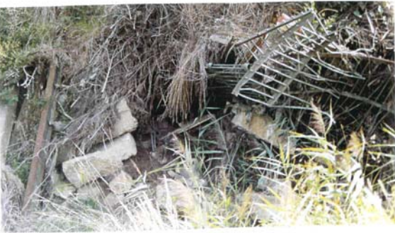
Photo 24 : des restes de décharge de gravats ... (secteur I)
