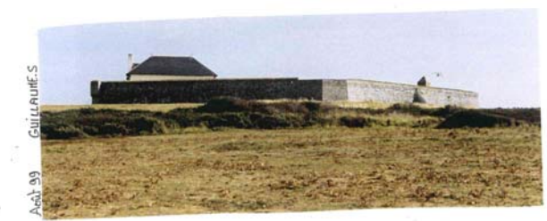
Photo 21 : le Fort du Loc'h , monument historique
