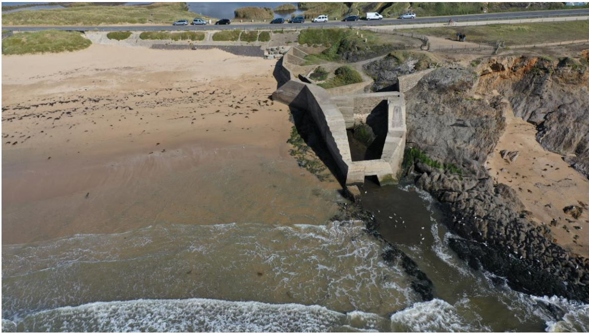
Ouvrage de sortie en mer de la Saudraye
