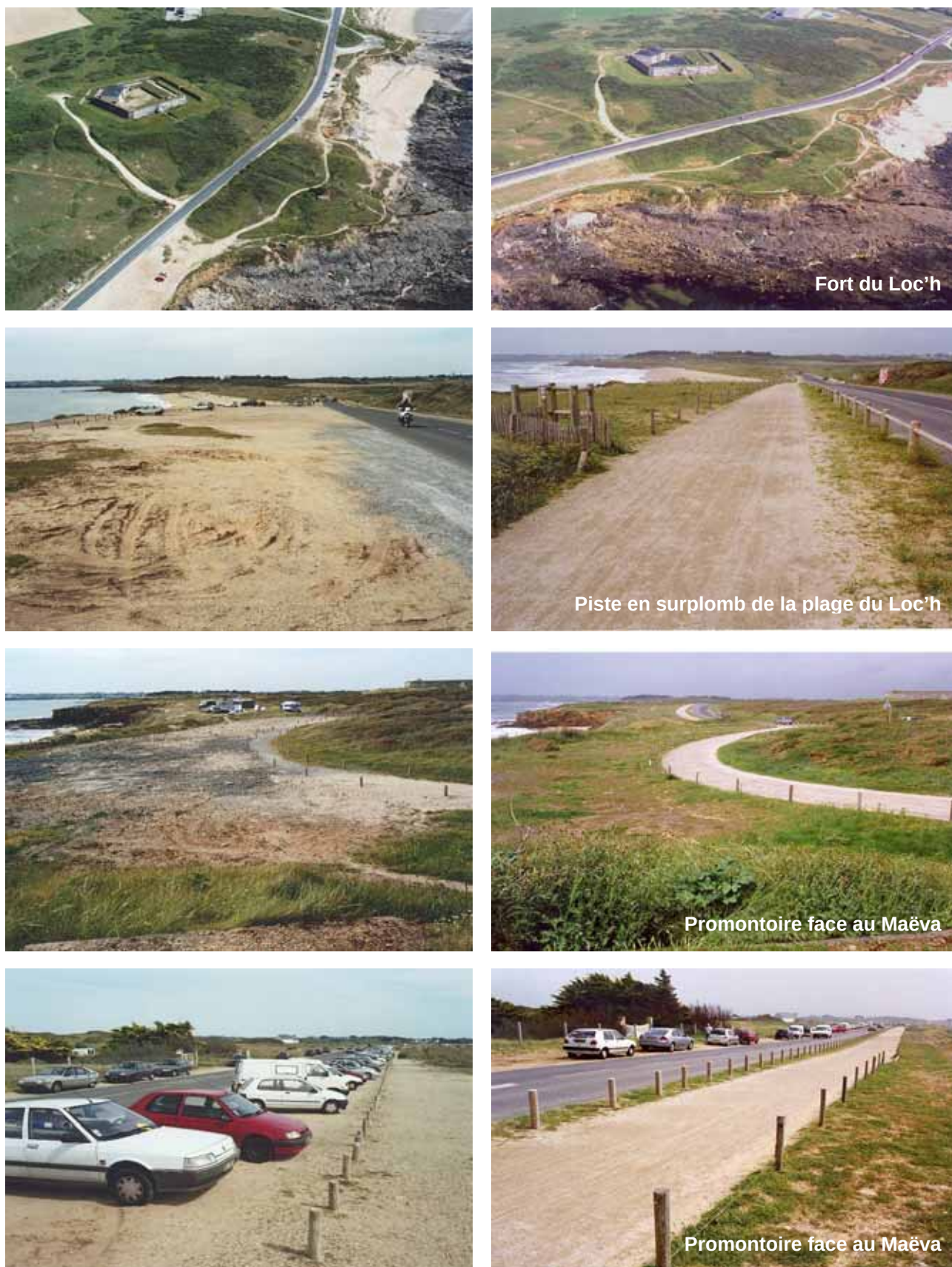
Figure 7 : Partie Guidel - Vues aériennes du site avant et après les travaux de réalisation de l'itinéraire piéton-vélo (À gauche : Marc Rapillard 2005, à droite : Armel Istin 2007)
